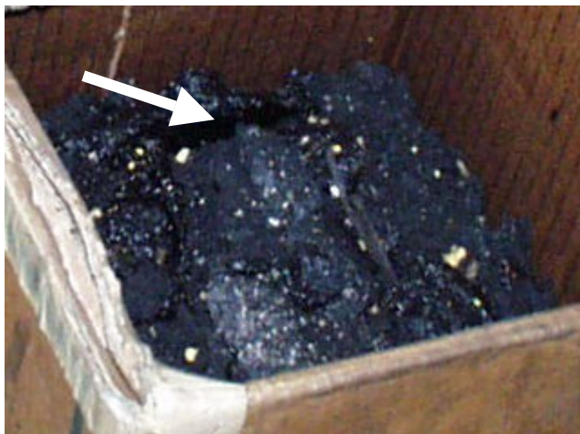
Rys. 7. Nagar usunięty z kanału spalin wylotowych zasilających turbosprężarkę jednego z bloku cylindrów silnika M401A2
