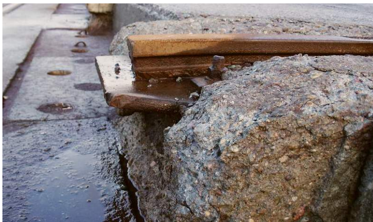
Fot. 2. Trwale odkształcony kraniec szyn stałej lądowego podnośnika okrętowego
