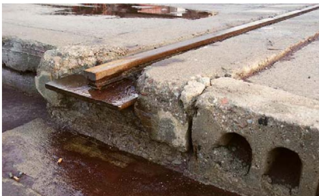
Fot. 1. Graniczny fragment stałej części lądowego podnośnika okrętowego
