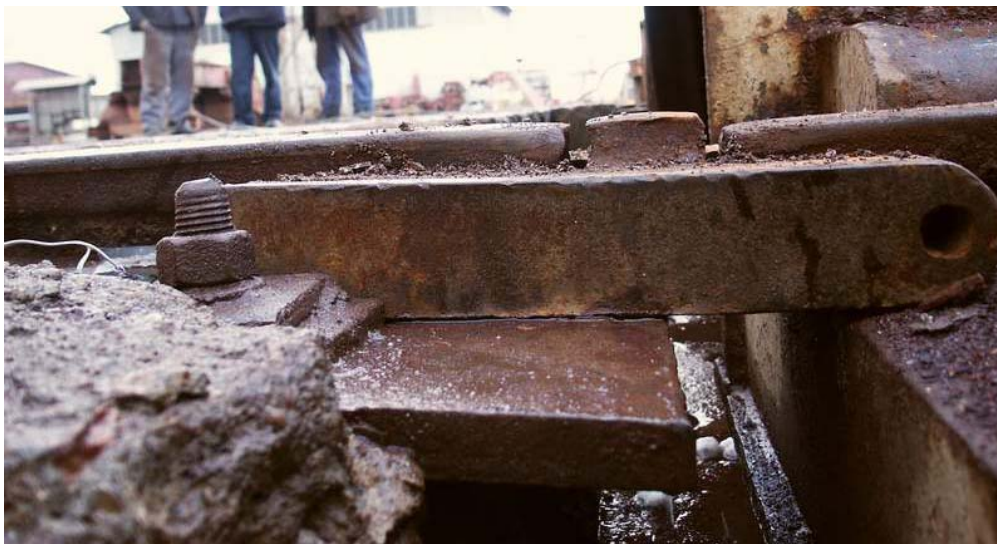
Fot. 1. Obszar łączenia szyn obszaru stałego i ruchomego lądowego podnośnika okrętowego z szyną pośrednią
