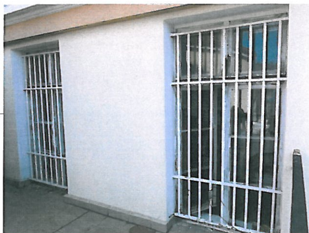
Zdj. nr 25 – okna wychodzące na taras z kratami
