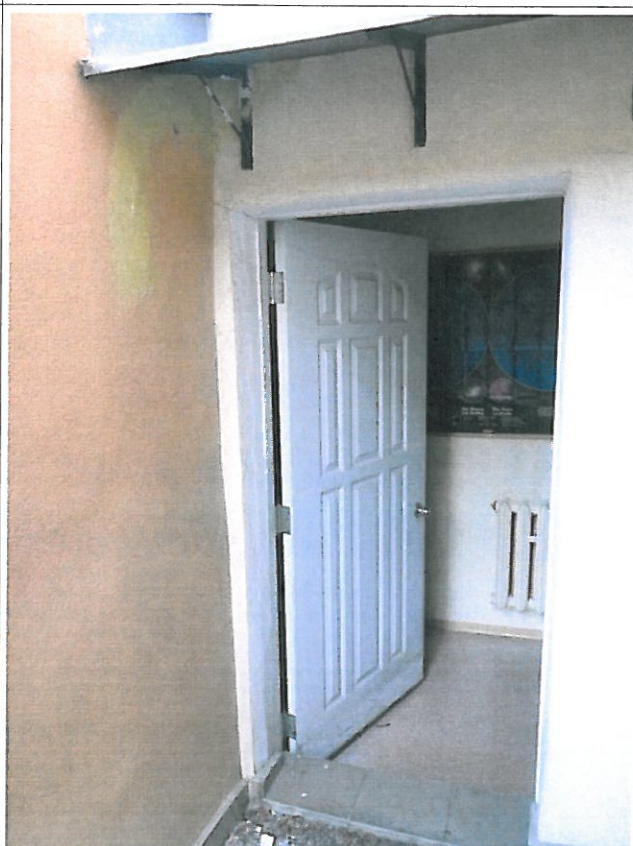
Zdj. nr 31 – drzwi zewnętrzne do pom. Nr 4
